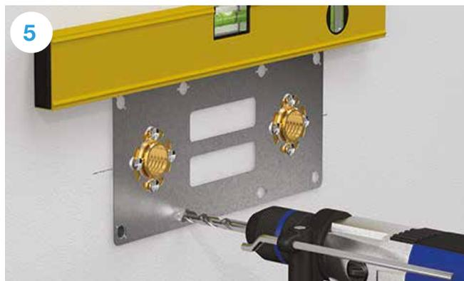
5 Posizionare orizzontalmente la piastra e praticare 4 fori ( $\varnothing 8\text{mm}$ ) per il fissaggio.
