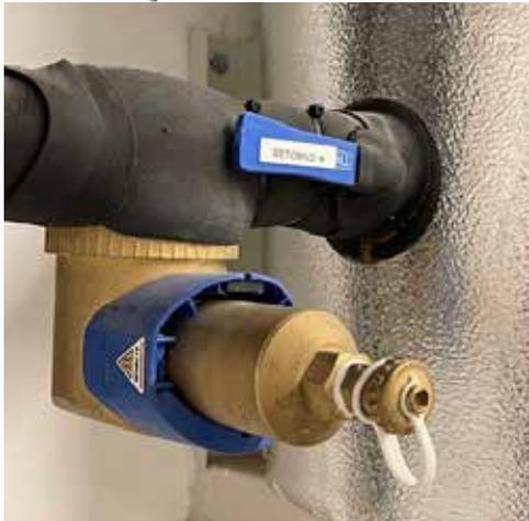
El **quitafundos magnético WSS** es uno de ellos: se trata de un componente que, mediante una acción mecánica que aprovecha la fuerza centrífuga del agua, tiene la misión de separar todas las impurezas que puedan encontrarse en el interior del circuito cerrado de calefacción, como sedimentos, residuos ferrosos, lodos, caliza, etc.
