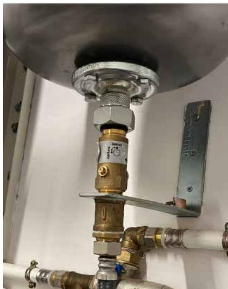
Para compensar las variaciones de volumen del fluido caloportador en el circuito de calefacción, se ha instalado el **vaso de expansión ACS/AFE**, que evita que el aumento de presión en el sistema dañe las tuberías y los componentes.
